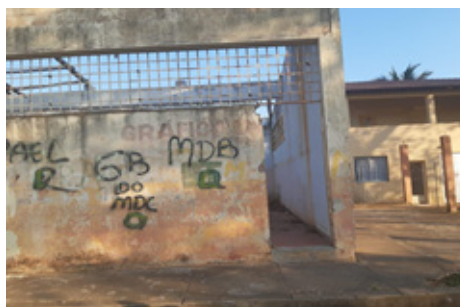
Foto do fundo e acesso ao galpão.
